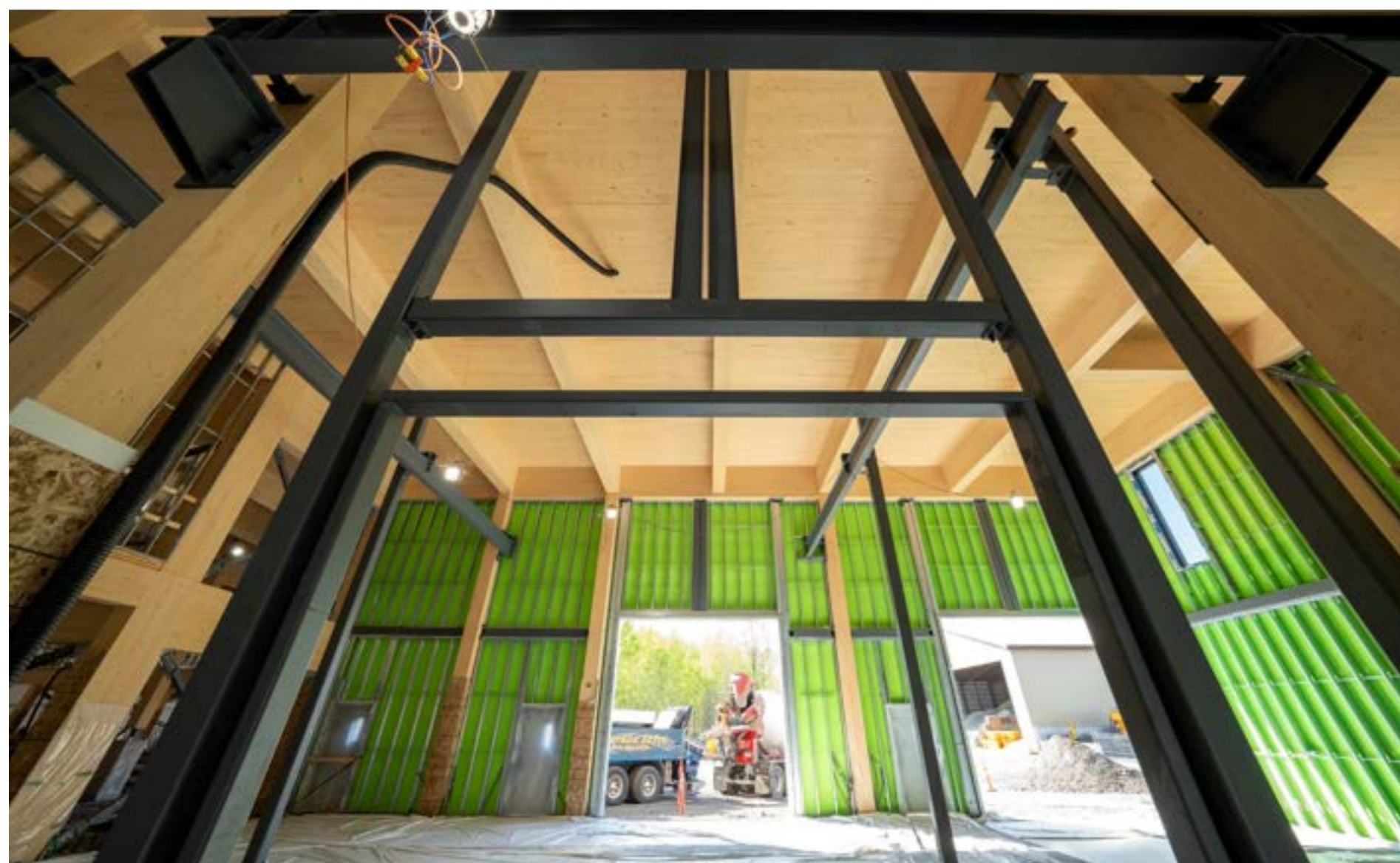
Photos : Construction Gératek
